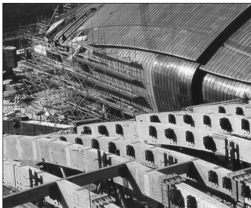
Fig. 18.4 - Una delle fasi di posa in opera della copertura
