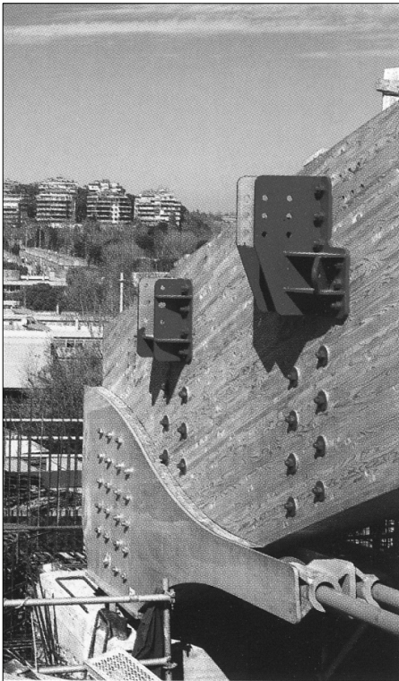
Fig. 18.9 - Dettaglio dell'appoggio delle strutture lamellari
