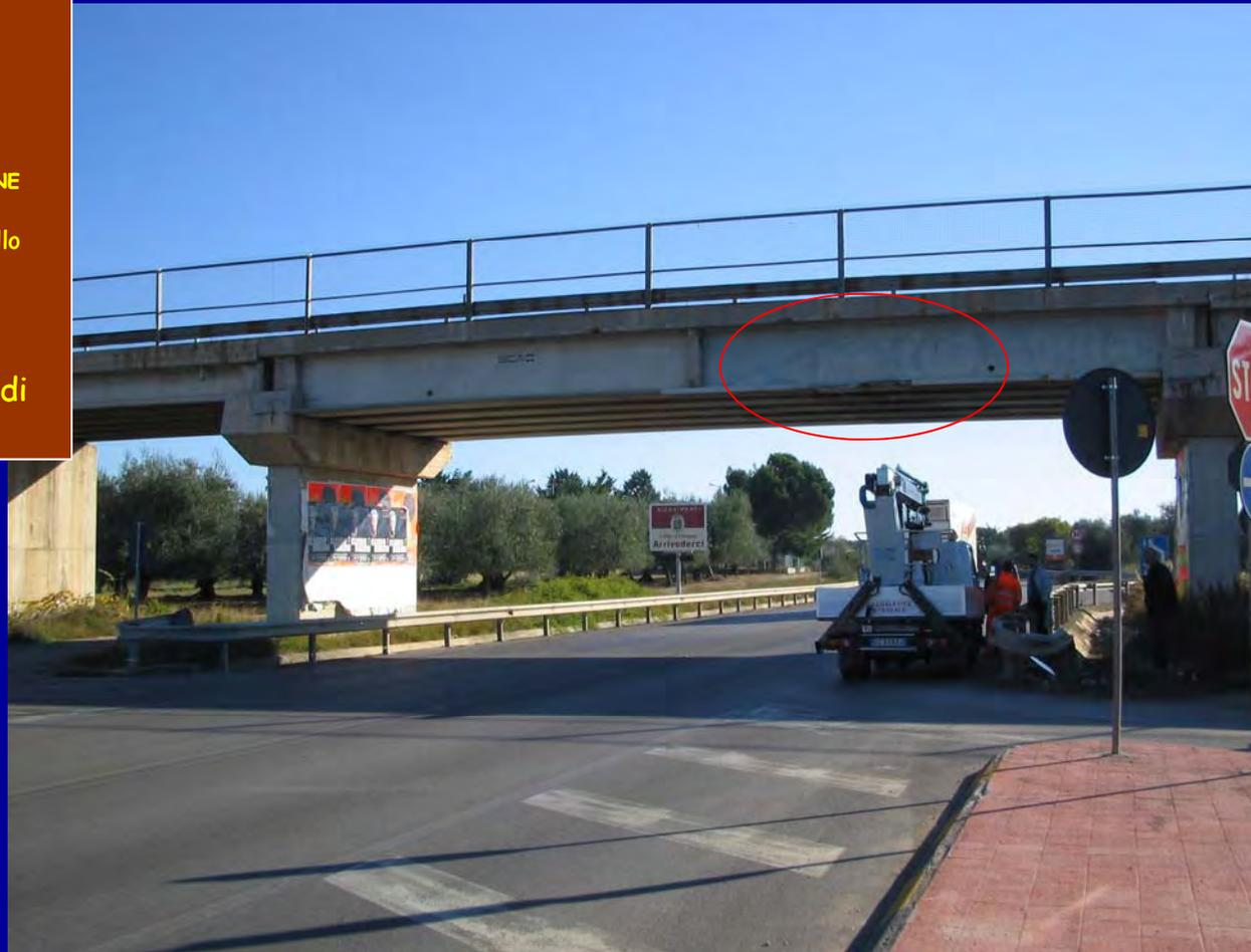
Foto A.2. (16.11.2006) Vista della campata centrale. In primo piano la trave danneggiata dall'urto
